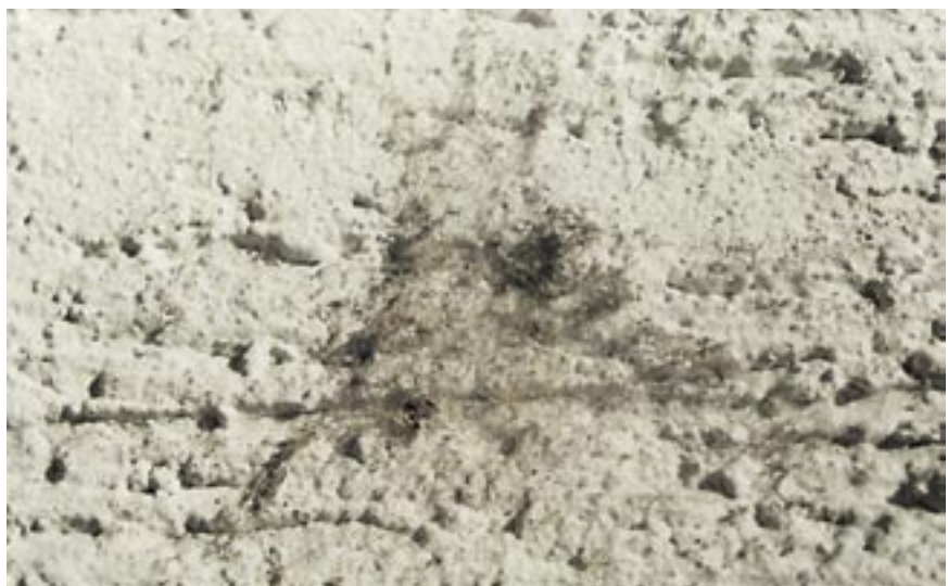
Bild 3 Mit Staub verschmutztes Netz
