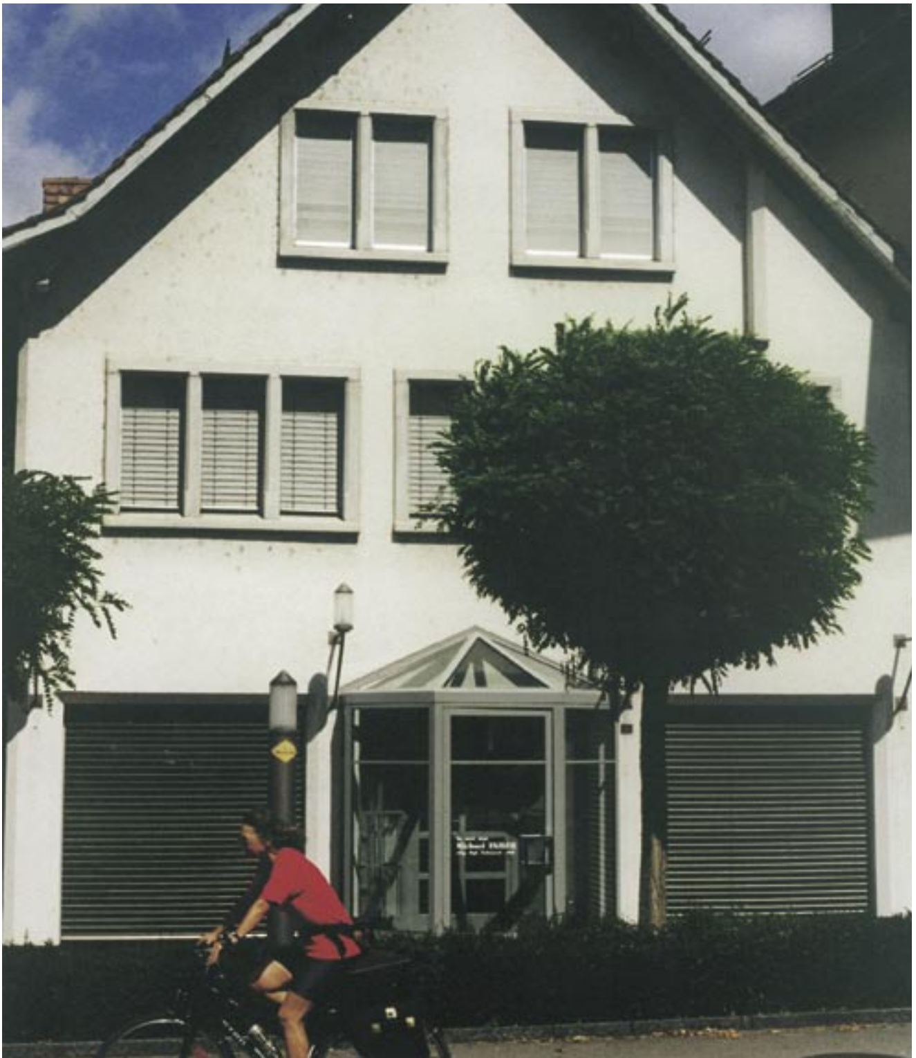
Bild 1 Fassade mit verstärktem Befall in geschützten Bereichen
